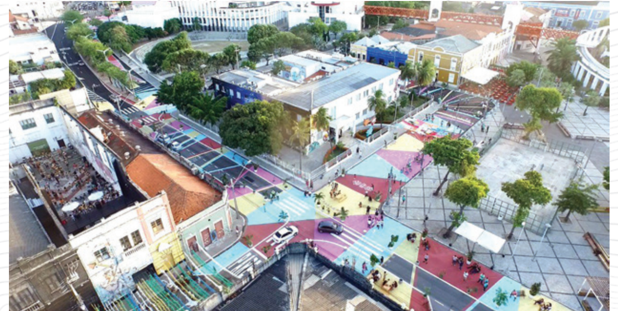
Escola Porto Iracema das Artes (centro da foto), inserida no complexo cultural do Centro Dragão do Mar de Arte e Cultura (entorno, ao fundo).
